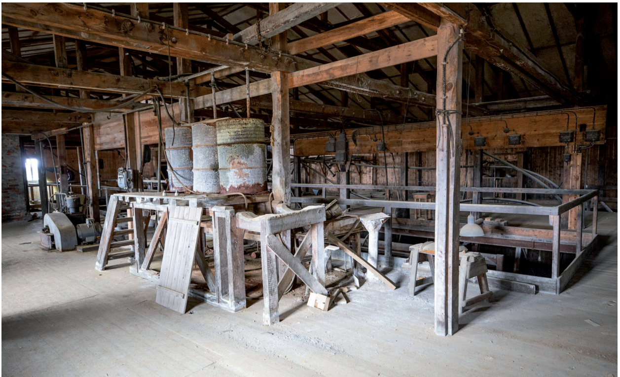
Flotasjonshallen, øvre dekk sett fra øst med kjemikalietønner for påsetting i flotasjonscellene som står på planet under.
